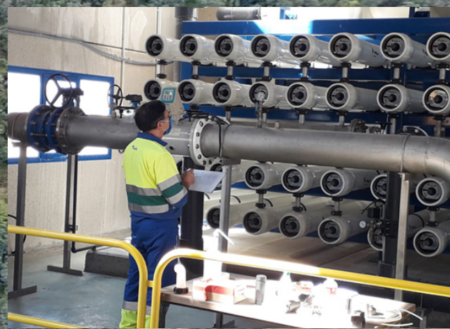
Operario de la ETAP El Girasol revisa la instrumentación de los bastidores de ósmosis inversa.
